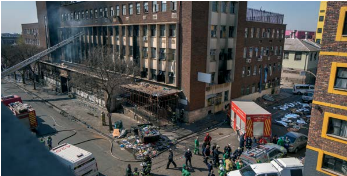
Das als Usindiso Shelter bekannte Gebäude nach dem tödlichen Brand im August.
