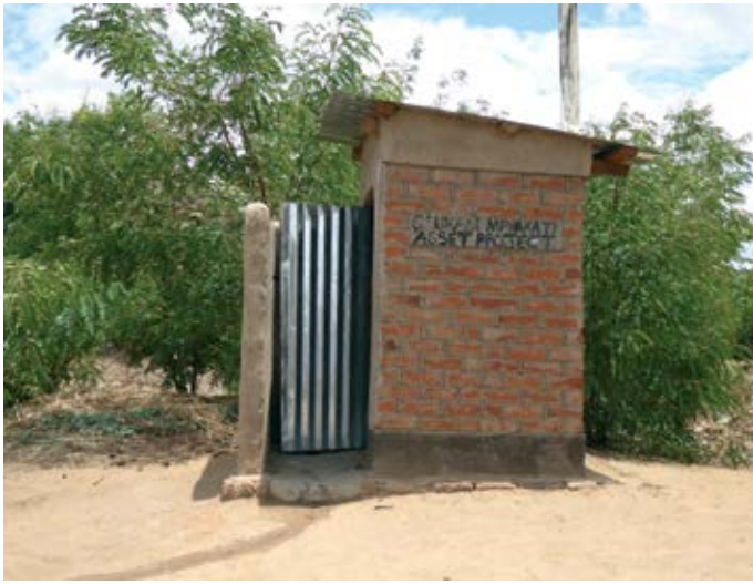
Toilette mit spezieller Belüftung.
