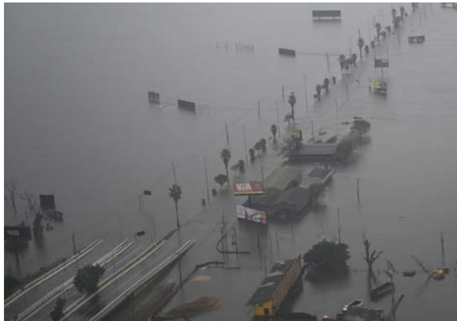
Überflutete Autobahn im Ballungsraum Porto Alegre im Mai 2024.
