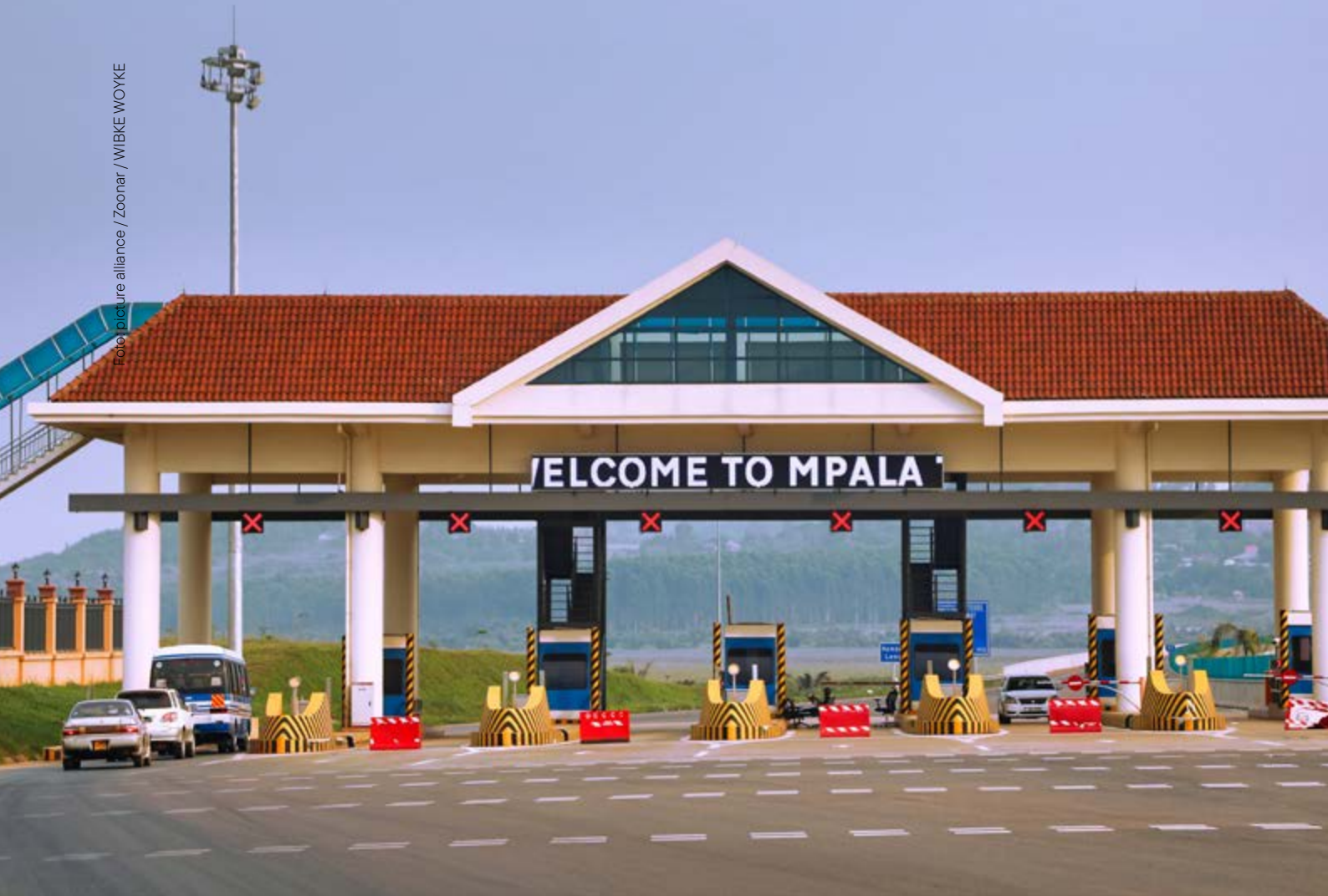
Die von China gebaute Entebbe-Schnellstraße in Uganda.
