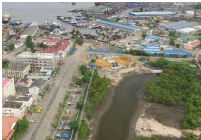
Das Sperrwerk wird Überflutungen im Stadtkern von Beira verhindern.
