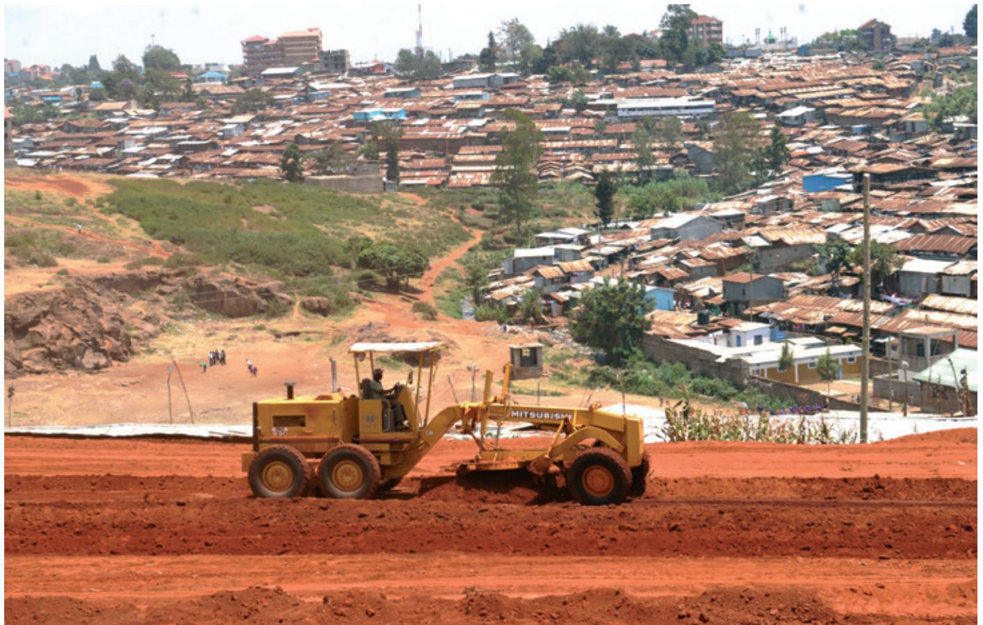
Straßenbau, wie hier in Kenia, gehört zu den Infrastrukturmaßnahmen, bei denen der CO 2 -Preis eine Rolle zu spielen hat.
