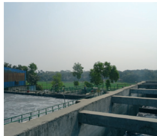
Die Textilfabrik Zaber & Zubair Fabrics in Bangladesch hat sich verpflichtet, die SDGs umzusetzen, und reinigt seine Abwässer in einem eigenen Klärwerk.
