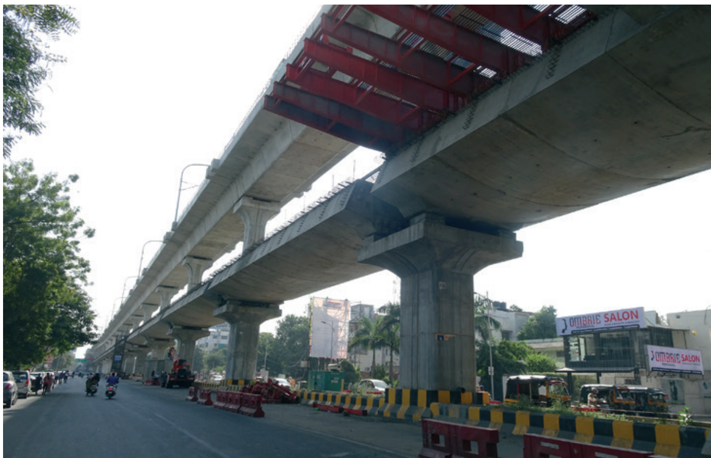
Besonders stolz ist Maha Metro auf ein 4,5 Meter langes Doppeldecker-Stück, auf dem Straße und Metro übereinander laufen.
