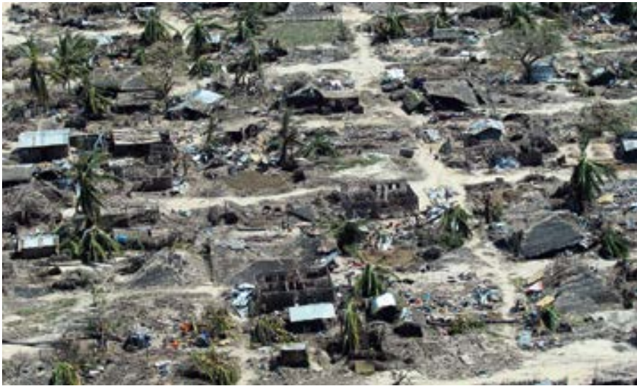
Zyklonschäden 2019 auf der mosambikanischen Insel Ibo.
