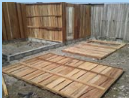
Die einfachen Wohneinheiten aus Holz werden in Modulbauweise hergestellt.
