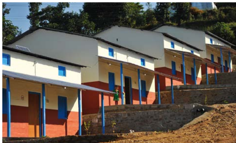
Beispiele für neu gebaute integrierte Siedlungen.
